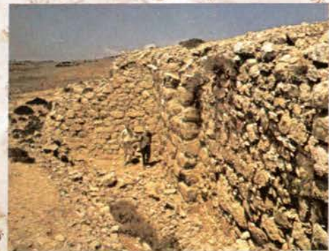
Todavía se conservan en Mizpá las ruinas de las murallas que el rey Asa edificó en el siglo X a.C. para proteger a Jerusalén de los múltiples ataques que provienen del norte.
